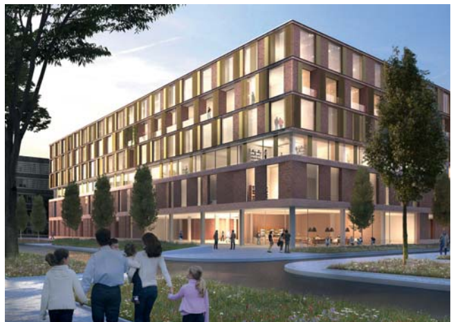
Außenansicht des neuen Herzzentrums
